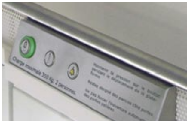
5 Habillage poutre guide
